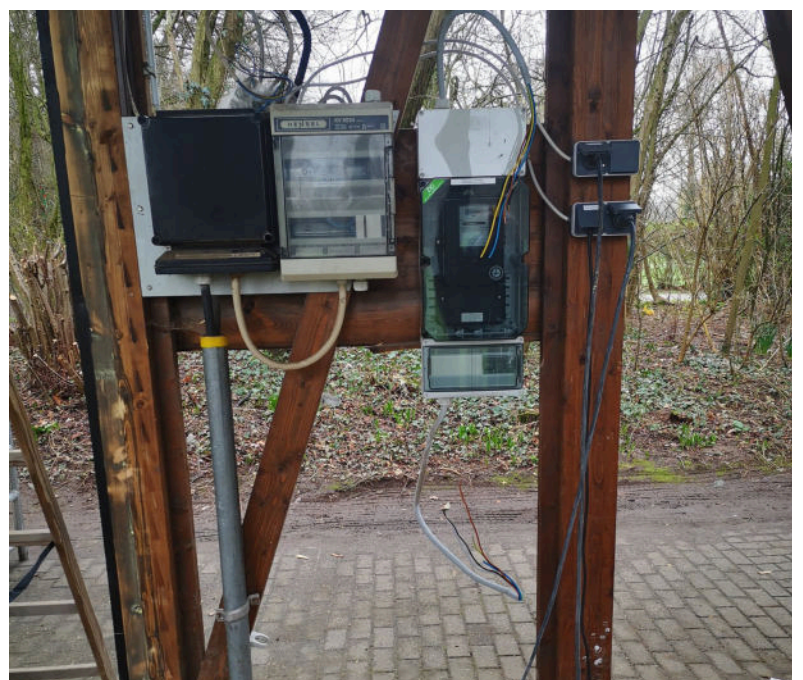
Die veraltete Elektroanlage stellte eine besondere Herausforderung dar. Im Zuge der Neuinstallation der Stromleitungen wurde vorausschauend auch die Infrastruktur für eine spätere Installation von Heizstrahlern geschaffen.
