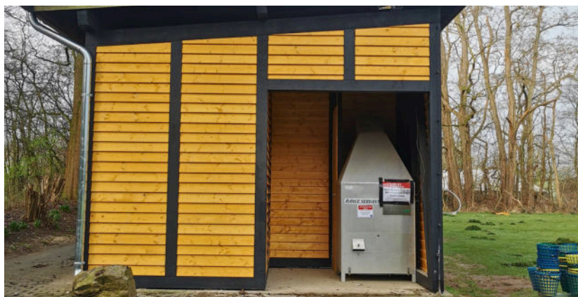
Die Abschlagshütte während der Bauphase: Die Front ist fast fertiggestellt, jedoch fehlen noch die neuen Türen und der Innenausbau.
