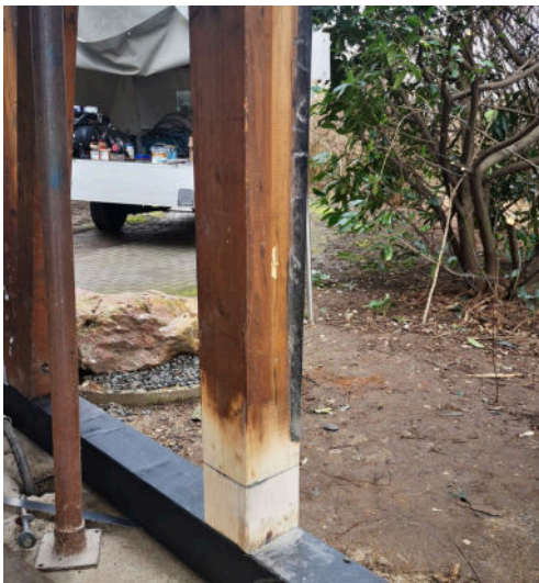
Einige Stützpfeiler waren stark abgenutzt und teilweise vermodert. Dank der professionellen Arbeit der beauftragten Firmen konnten sie fachgerecht wieder instand gesetzt werden.
