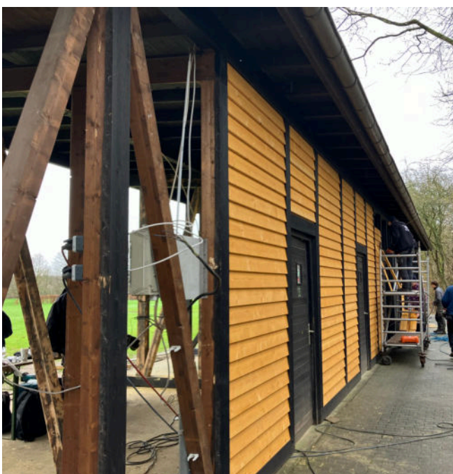
Die Abschlagshütte während der Bauphase: Die Front ist fast fertiggestellt, jedoch fehlen noch die neuen Türen und der Innenausbau.
